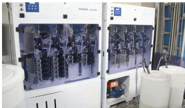
▲上がバッチ用のエアードイヤフラムポンプ Wash Multi Air (エアブースター)、下が連洗用エアードイヤフラムポンプ WashDose Tunnel
