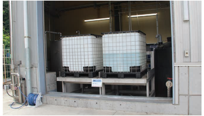
▲過酢酸のコンテナ（1トン）から連洗とバッチに直接供給する
