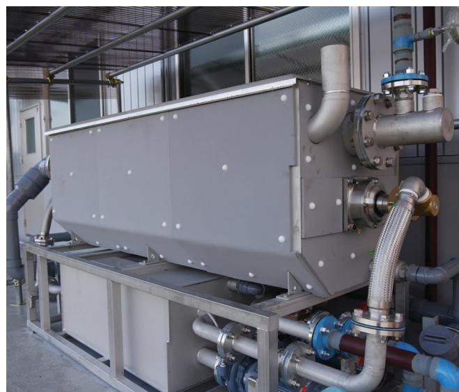
▲連洗、水洗機の排水から熱回収を行う装置。温水をつくるコストを削減できるため、水の再利用装置とともに近年、リネンサプライ工場での導入が進んでいる
