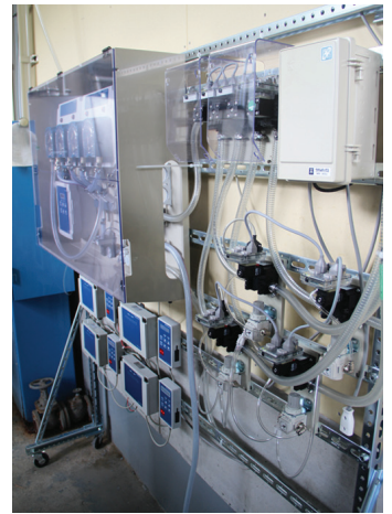
▲過酢酸のコンテナ（1トン）から連洗とバッチに直接供給する
